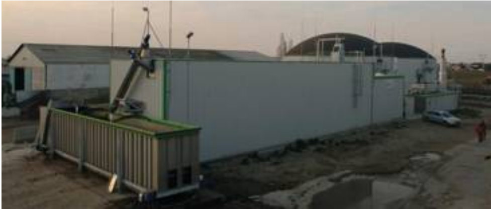
● Due immagini dell'impianto di biogas da 845 kW costruito a San Pietro in Campiano (Ra) con incentivi pubblici.
